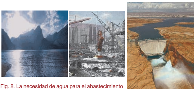
Fig. 8. La necesidad de agua para el abastecimiento humano, animal y los riegos ha obligado a incrementar drásticamente el número de pantanos en el mundo y su envergadura. En la imagen, detalles del embalse de Riaño (León), la presa que se construye en China (Tres Gargantas) de más de 185 m de altura, y el de GlenCanyon en USA, lo que supone importantes cambios en el ambiente que exigen pormenorizados estudios de impacto ambiental previos y medidas correctoras ( www.eng.ucalgary.ca/ CSCS-Students/structural_... )
